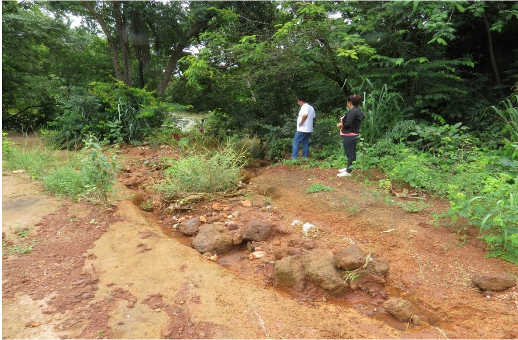
Foto 067: Sedimentos arrastados pela enxurrada, causando forte erosão às margens do rio Manoel Alves em Porto Alegre do Tocantins, falta de sistema de drenagem urbana a montante (IBRAMAR, 11/01/2022)
