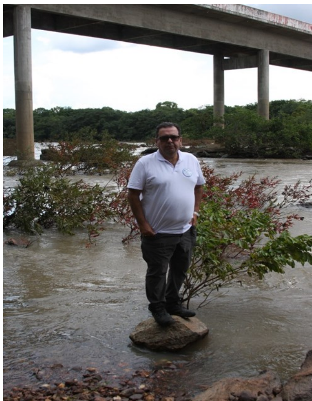
Foto 02: Ponte sobre o Rio Manoel Alves, Natividade, TO (IBRAMAR, 26/11/2021)
