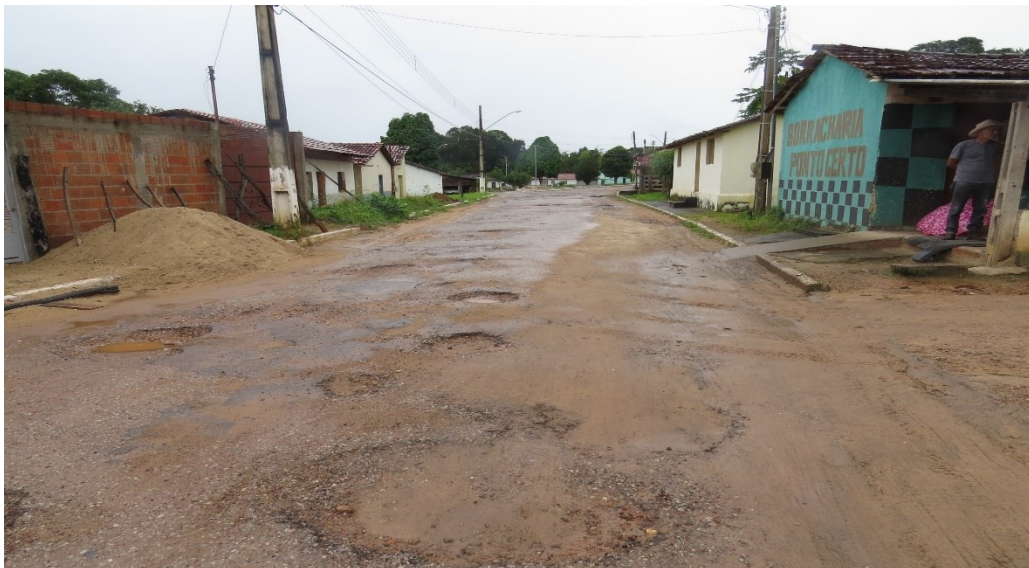
Foto 066: Falta de sistema de drenagem urbana, Rio da Conceição (IBRAMAR, 11/01/2022)
