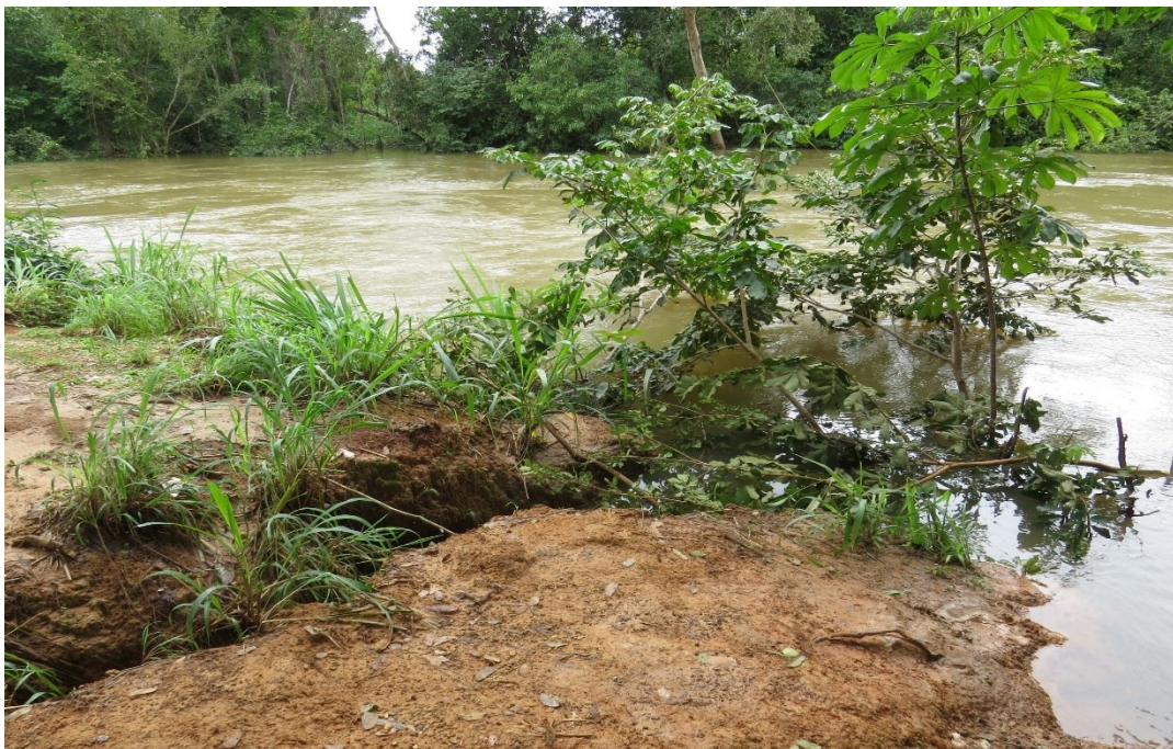
Foto 068: Assoreamento e carreamento de sedimentos às margens do rio Manoel Alves em Porto Alegre do Tocantins, falta de sistema de drenagem urbana a montante (IBRAMAR, 11/01/2022)
