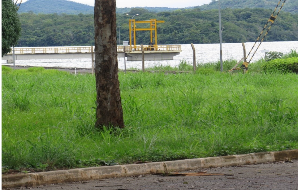
Foto 012: Represa e PCH no Rio Manoel Alves, Projeto de Irrigação, Dianópolis, TO (IBRAMAR, 21/01/2022)
