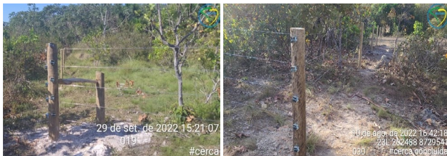
Fotos 6.9 – Atividade de proteção de áreas - Cercamento
