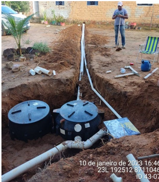
Foto 6.15 - Instalação do biodigestor em fase de conclusão
