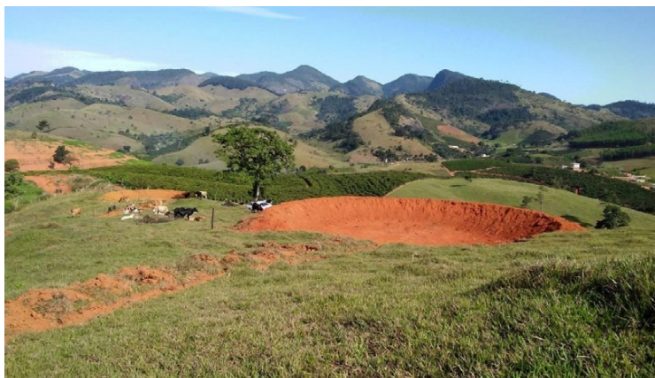
Figura 51 - Barraginha em formato circular
