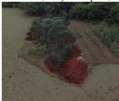
Figura 32 - Voçoroca em área de nascente (manejo inadequado)
