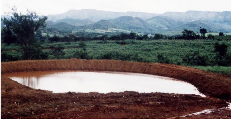
Figura 49 - “Barraginha” construída na bacia do rio Gorutuba
