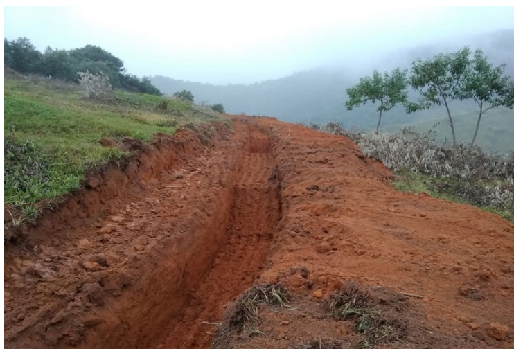
Figura 54 - Coxinhos em nível sendo construídos no município de Atilio Vivacqua (ES)
