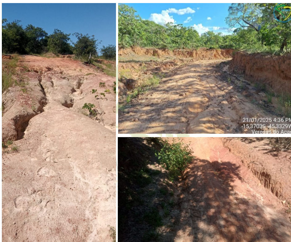
Figura 53: Estradas identificadas na área do projeto
