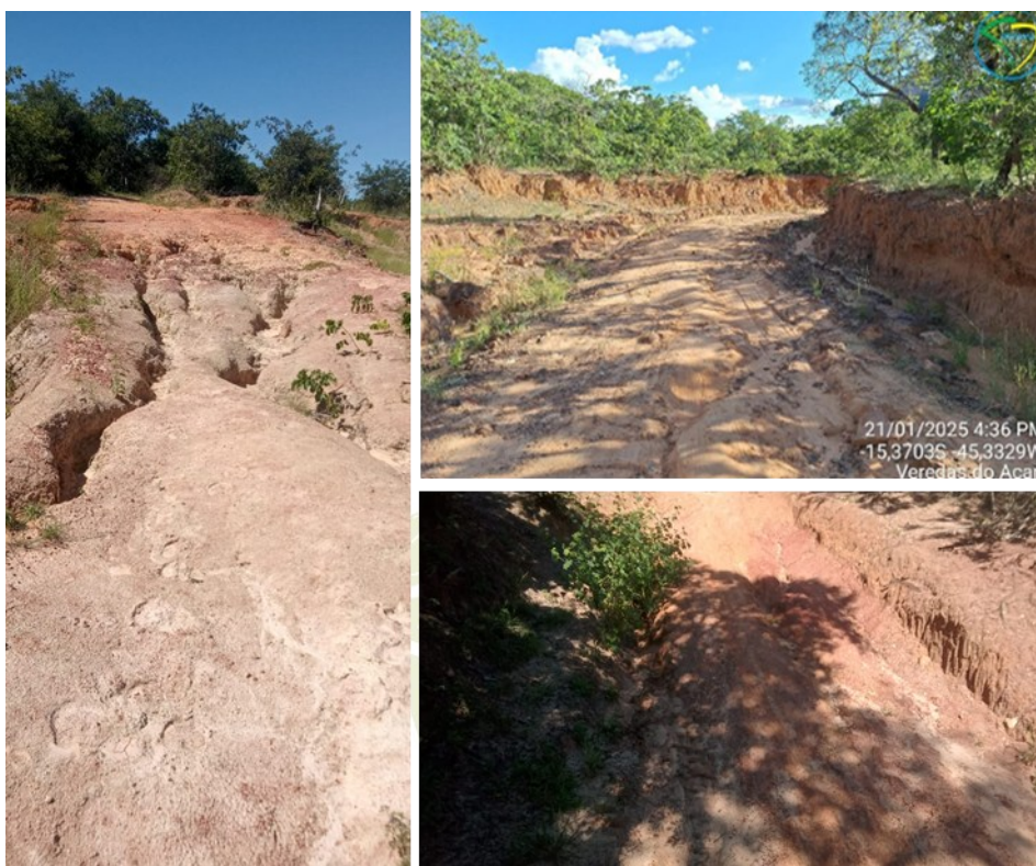
Figura 26: Estradas identificadas na área do projeto
